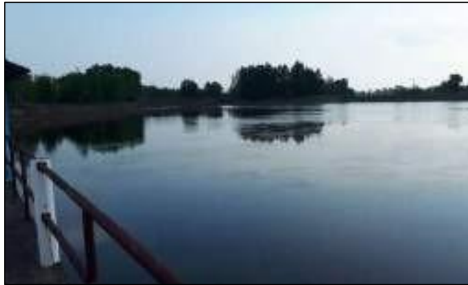
Gambar 3.34 Kolong Perawas – IPA Perawas
