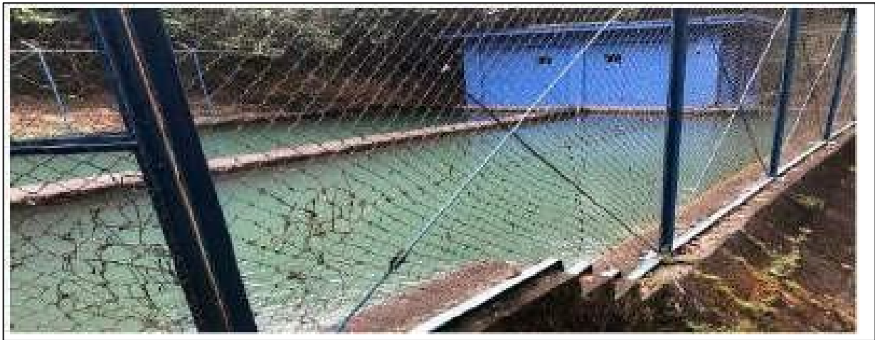
Sumber: Review Dokumen RISPAM Kabupaten Bangka Barat, 2021
