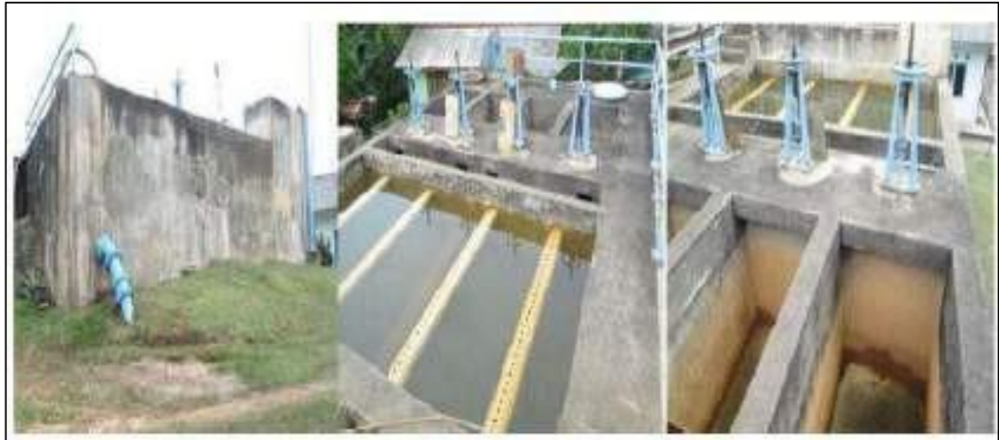
Sumber: Review Dokumen RISPAM Kabupaten Bangka Barat, 2021
