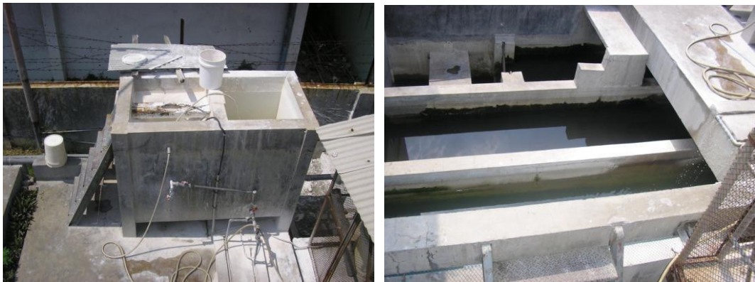
Gambar 3. 9 Contoh bak kontaklor klorine untuk proses disinfeksi
