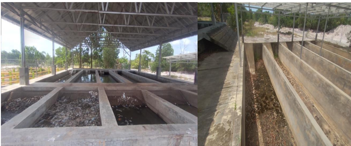
Gambar 2. 20 Kondisi Eksisting IPLT Kabupaten Belitung Timur
