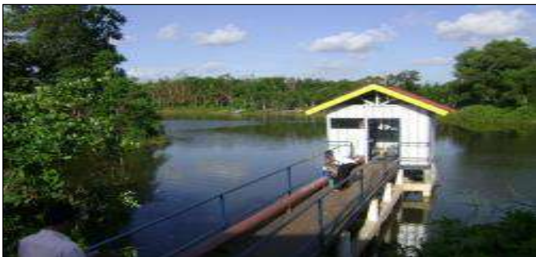
Sumber: Rencana Induk Sistem Pengolahan Air Minum (RISPAM) Kabupaten Bangka Selatan, 2015 Gambar 3-65 Intake (Unit Parit 9)
