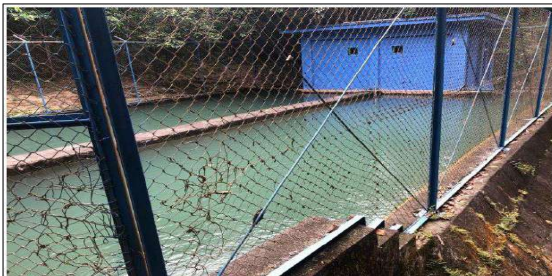
Sumber: Review Dokumen RISPAM Kabupaten Bangka Barat, 2021 Gambar 3-36 Watervank Manumbing
