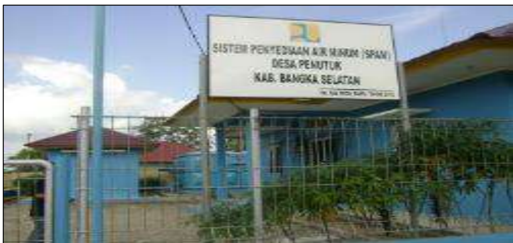
Sumber: Rencana Induk Sistem Pengolahan Air Minum (RISPAM) Kabupaten Bangka Selatan, 2015 Gambar 3-74 IPA SPAM IKK Lepar Pongok
