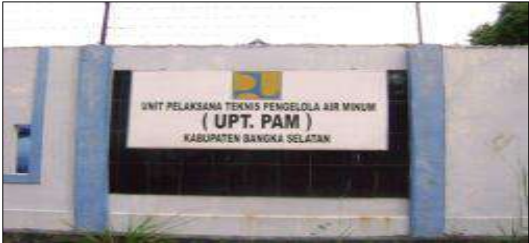
Sumber: Rencana Induk Sistem Pengolahan Air Minum (RISPAM) Kabupaten Bangka Selatan, 2015 Gambar 3-66 IPA SPAM Baher
