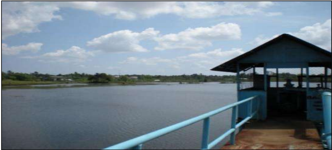
Sumber: Penyusunan Masterplan Distribusi Pelayanan PDAM, 2016 Gambar 3-78 Kolong Dukong & Intake (unit SDukong I)
